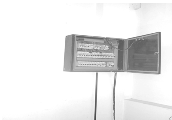
Foto N° 21 – Vista de un tablero seccional en el estacionamiento sin contratapa quedando todos los conductores eléctricos expuestos .
